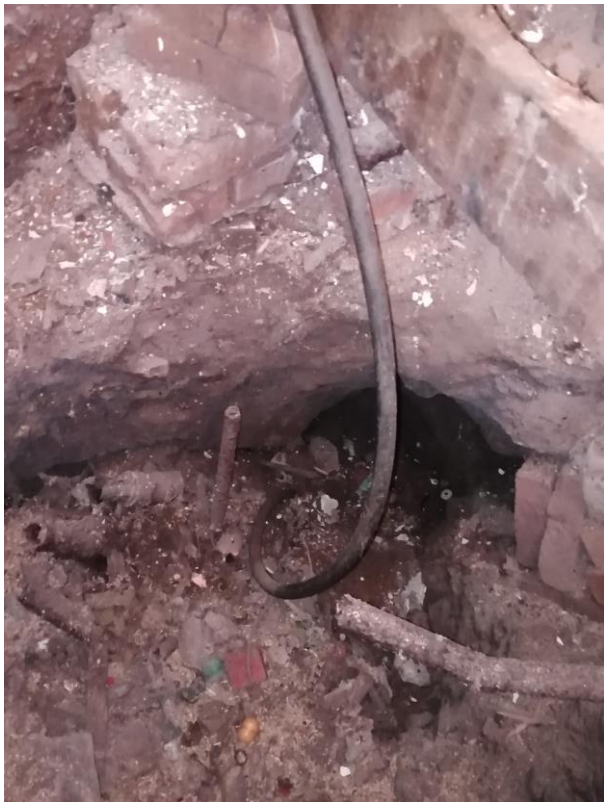
Вскрытие трещины в отделочном слое цоколя, конструкция кирпичного цоколя не деформирована
