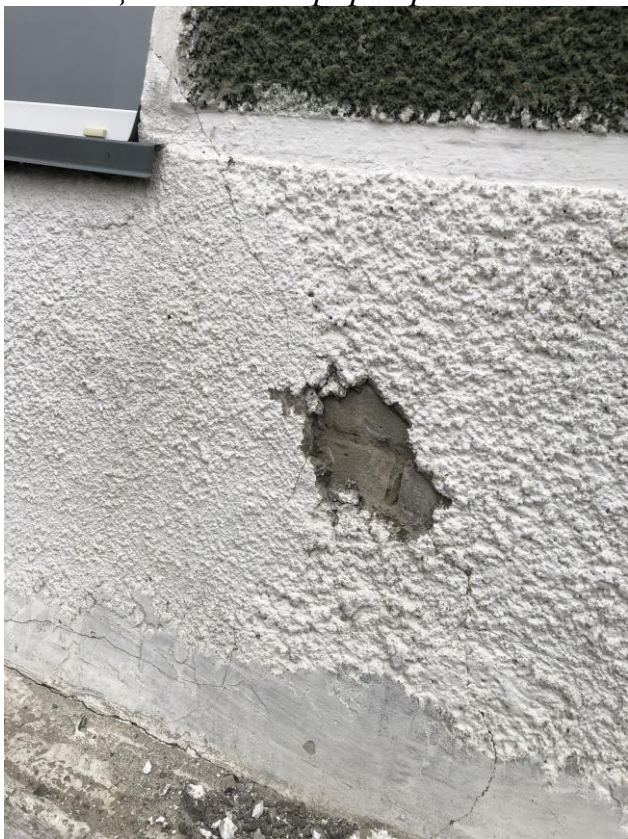
Вскрытие трещины в отделочном слое цоколя, конструкция кирпичного цоколя не деформирована
